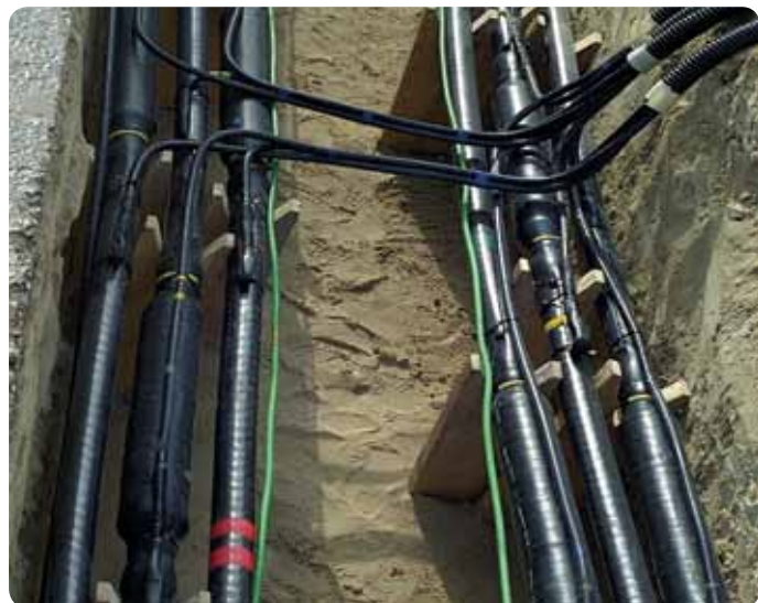
EHVS - emenda para cabos isolados até 72 kV.
